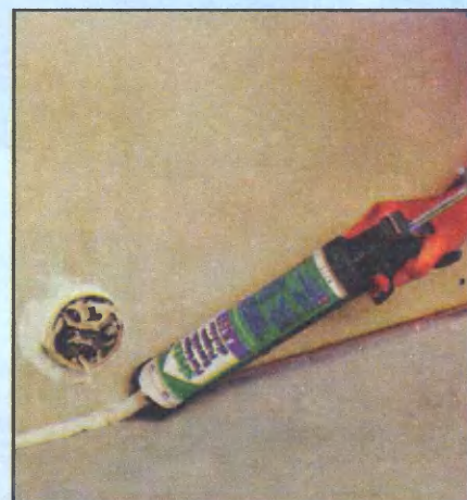
Зазор внизу у пола заделывают герметиком, защищающим кромки обшивки от влаги.
