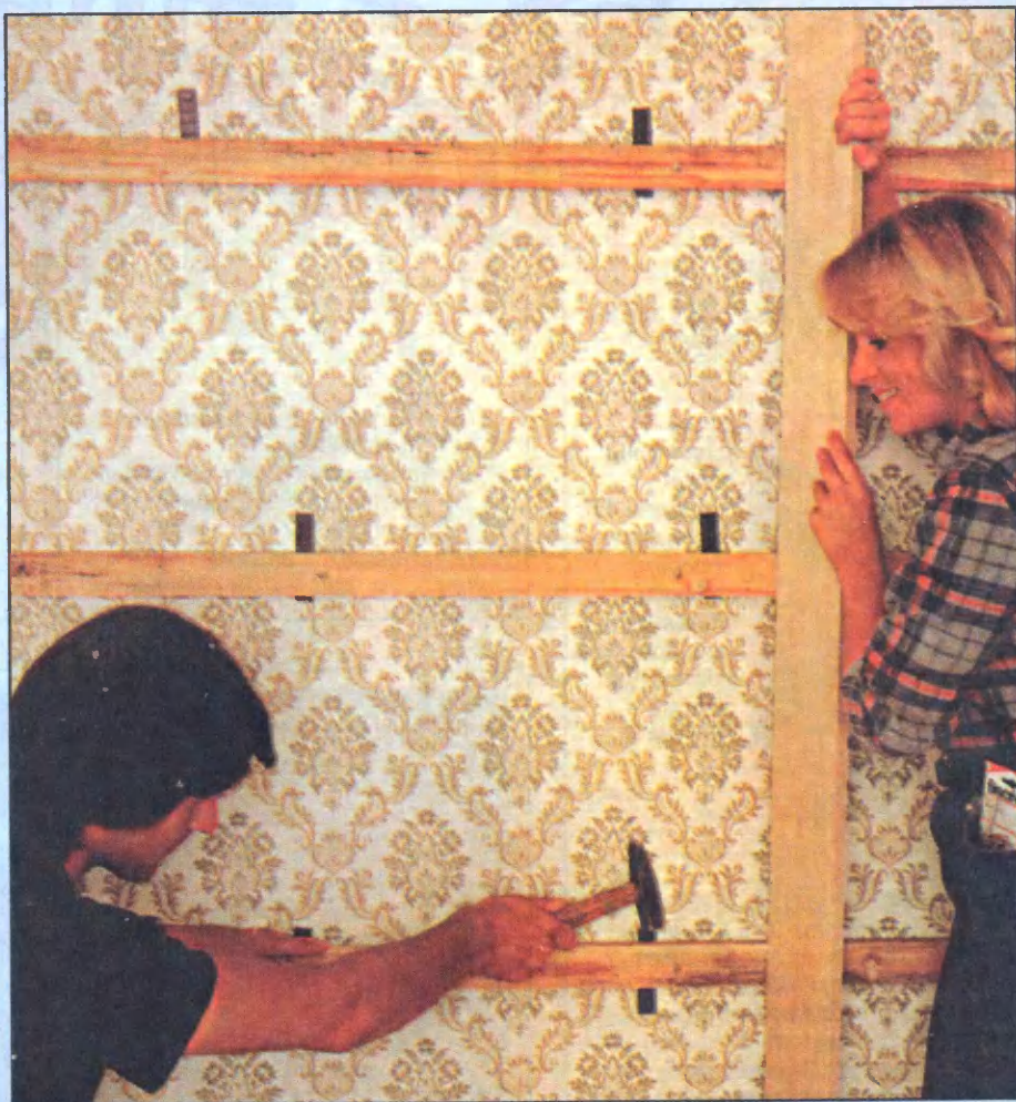
Обшивку внутренних стен в жилых домах ведут по обрешетке из реек. При неровности стен необходимую жесткость обрешетки обеспечивают дополнительными опорами – клиньями, забиваемыми под рейки.
