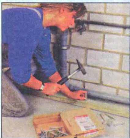
Бруски каркаса крепят на длинных распорных дюбелях.
