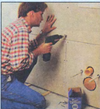
При обшивке каркаса незаменим аккумуляторный электроинструмент с импульсным режимом работы.
