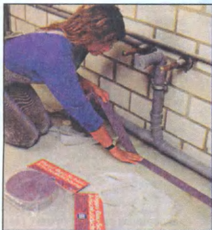
При возведении каркаса декоративной оболочки бруски 60х40 мм у потолка и пола монтируют на упругих прокладках.
