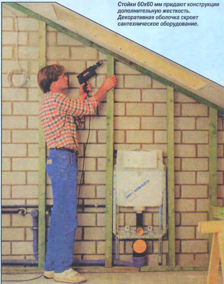
При возведении каркаса декоративной оболочки бруски 60х40 мм у потолка и пола монтируют на упругих прокладках.
